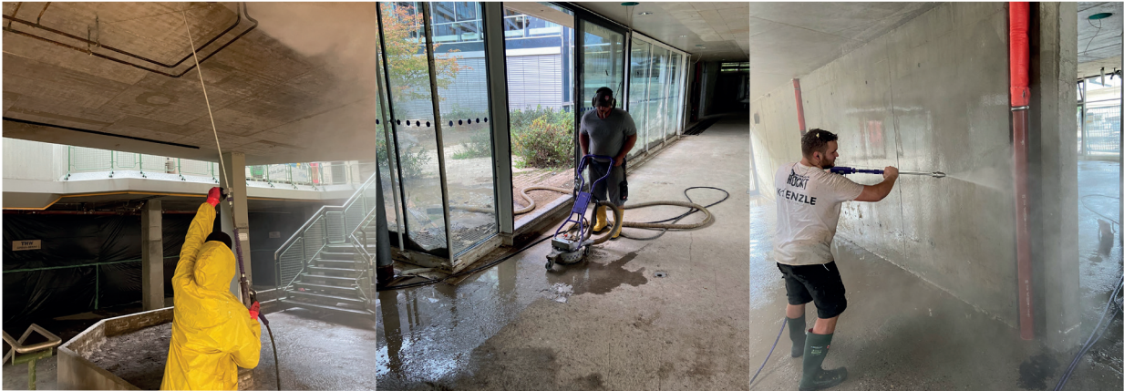
Profesionalno visokotlačno čiščenje do 500 barov v zaprtih prostorih.
