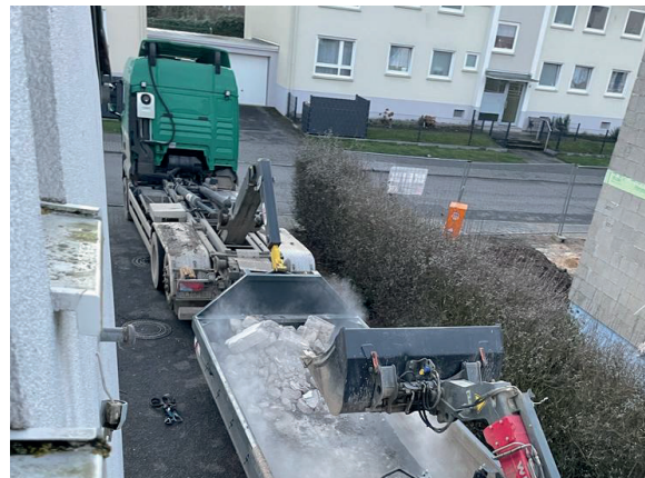
Odstranjanje gradbenih odpadkov s pomočjo teleskopskih manipulatorjev
