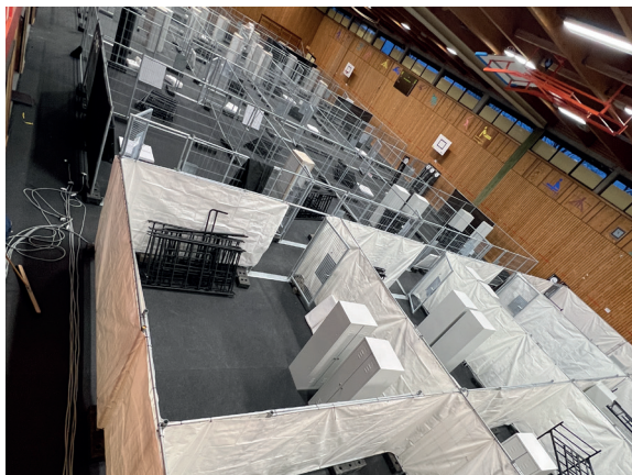
Gradnja začasnih zasilnih zavetišč.
