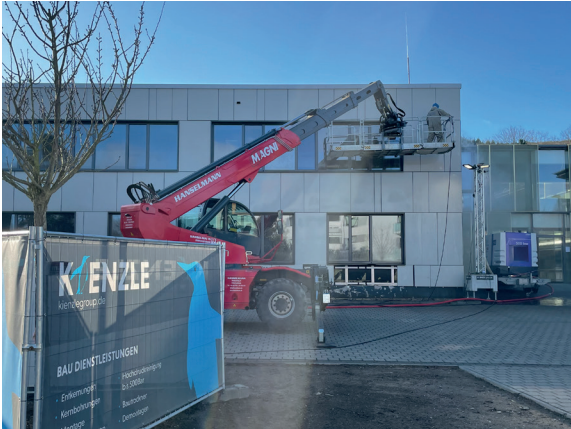
Mit dem Teleskoplader sind arbeiten in bis zu 21 Meter höhe möglich
