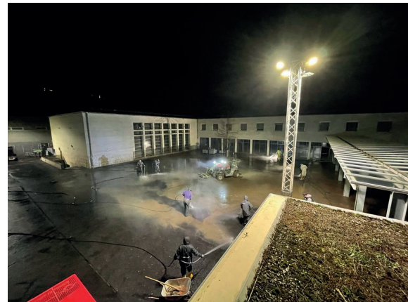
Professionelle Hochdruckreinigung im Außenbereich
