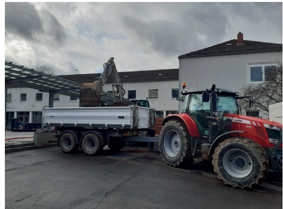
Transport von Bauschutt, Schlamm und sonstigem Geröll mit Erdmulde
