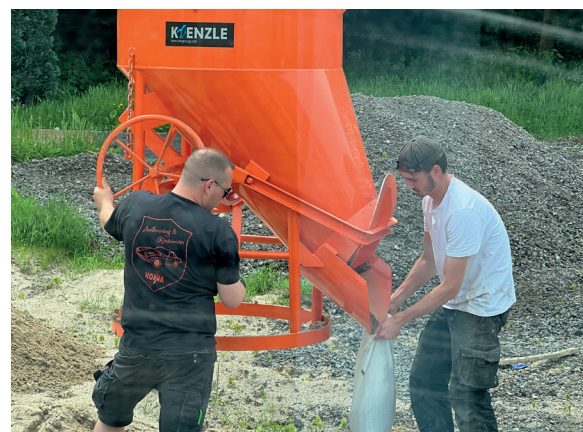
Befüllen von Sandsäcken
